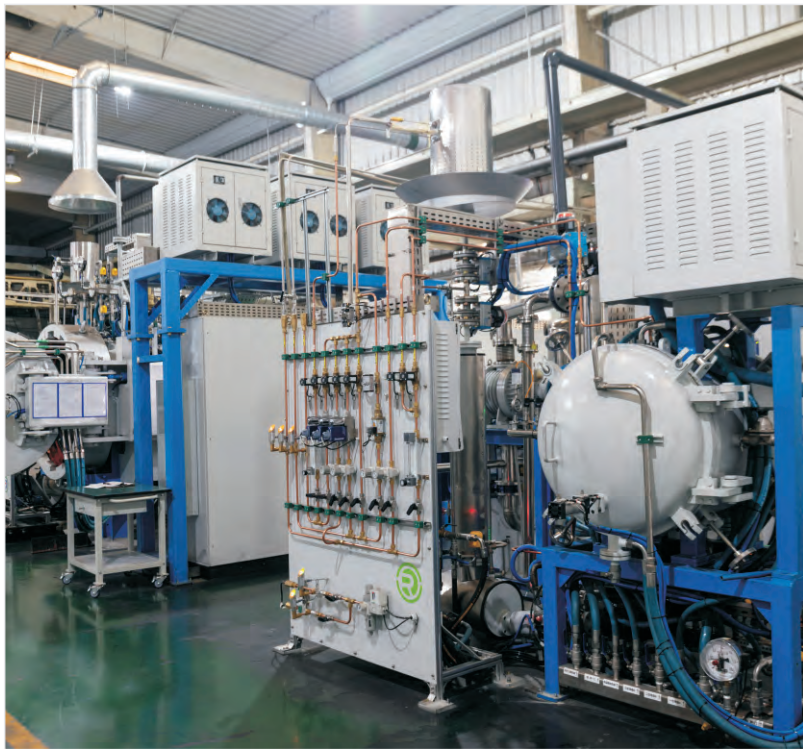
某所烧结炉配套特气工程
